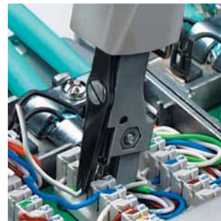
Eindringen und Abschneiden des Kabels in einem Arbeitsgang
