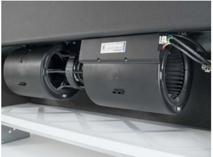
EC-Gebläse HKN 200–1400 EC fan of HKN 200–1400
