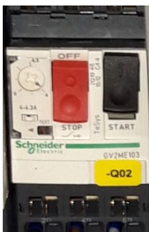
Abbildung 23: Leitungsschutzschalter mit Überstromschutz
