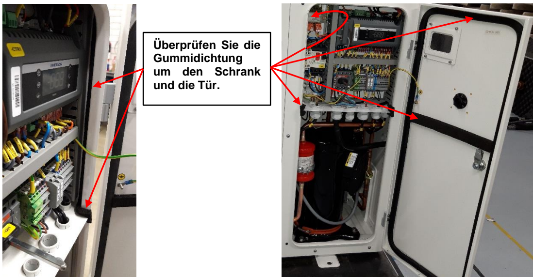
Abbildung 36: Sichtprüfung der Gummidichtung
