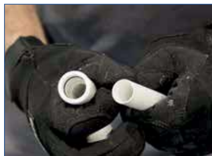
Schritt 3: vormontierter O-Ring prüfen (mit gleitmittel versehen)
