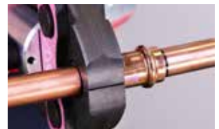
12. Pressen Sie den Fitting mit dem zugelassenen Presswerkzeug
