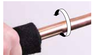
4. Reinigen Sie das Ende des Rohres
