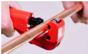
1. Kürzen Sie das Kupferrohr
