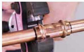
11. Führen Sie den Fitting in die Pressbacke
